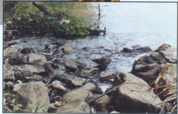
การวางหินซ้อนกันเป็นชั้น ๆ ลดหลั่นจนได้ระดับ
