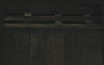
ช่องระบายลม สำหรับเรือนหลังคาทรงปั้นหย่า เรือนพื้นถิ่นเมืองเกิน
